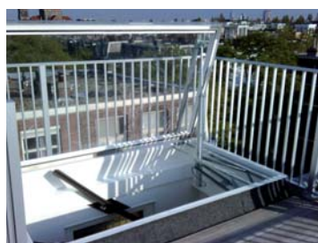
Dakbetreding, met elektrische bediening
